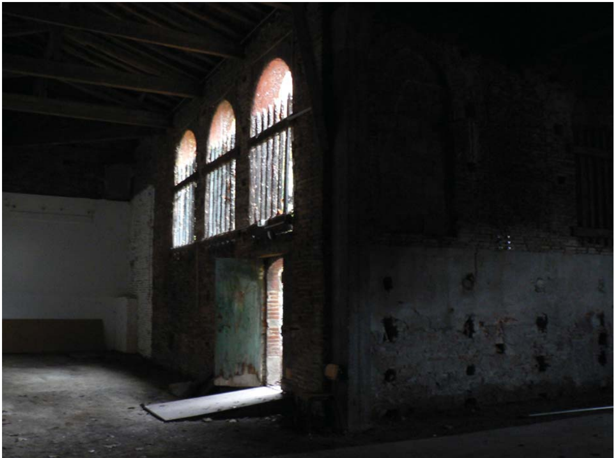
Intérieur de la maison éclusière Saint Pierre en 2009
